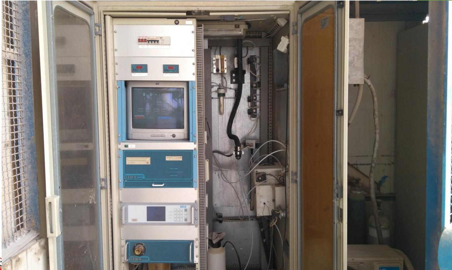
**Nouveau analyseur (Type ABB) : Mesure en continu de NO, NO<sub>2</sub>, SO<sub>2</sub>, CO, NH<sub>3</sub>, HCl, HF, CH<sub>4</sub>, COT (Carbone Organique Total)**
